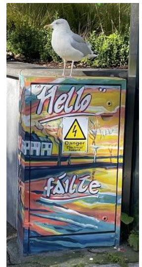
Sicherungskasten in Galway
